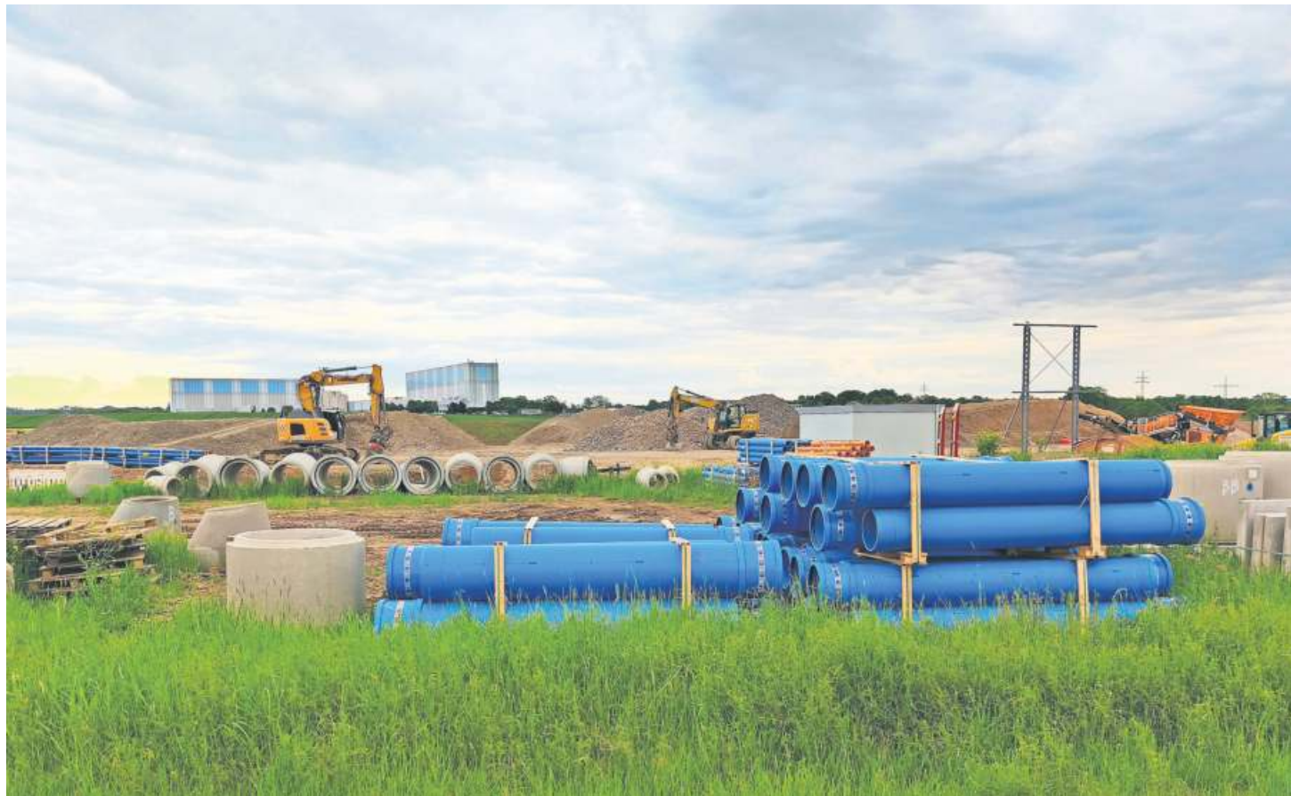
Die Arbeiten am Industriegebiet Süd schreiten voran. Knapp zehn Monate nach dem ersten Spatenstich im August 2025 sind die Fortschritte deutlich erkennbar.
