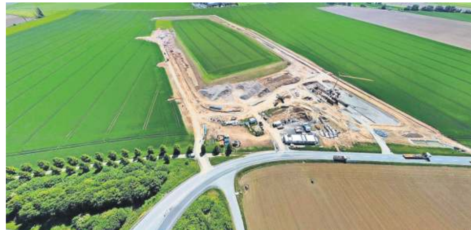
Das Industriegebiet Süd aus der Vogelperspektive. Zu erkennen ist auch die Landesstraße 2662, welche Heubisch mit der Bundesstraße 4 verbindet.
