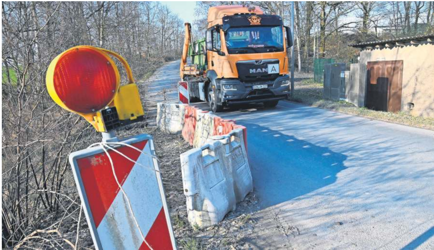
Die Sanierung der Rohgrabenbrücke ist eine der wichtigsten Investitionen in diesem Jahr.
