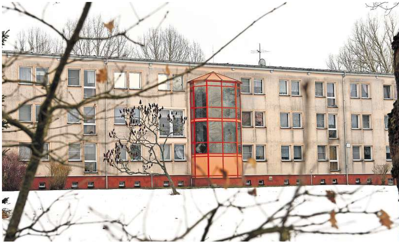
Das alte Seniorenheim in Oerlsdorf war einst eine Kaserne. Die 38 Bewohnerplätze verteilen sich auf drei Etagen.
