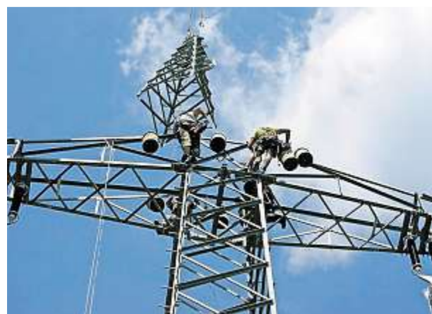
Die Arbeit ist beendet. Mast 313 reiht sich in die Strecke ein.
