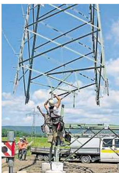
Sechs Tonnen Stahl schweben über den Köpfen.
