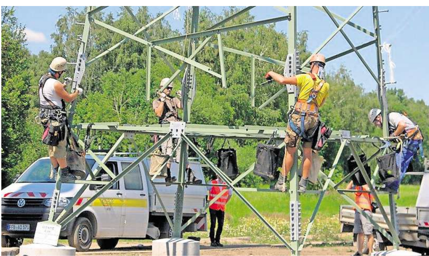
Teamwork: Vier Spezialmonteure verankern gleichzeitig Koloss und Sockel.
